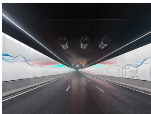
无锡高浪快速路隧道
