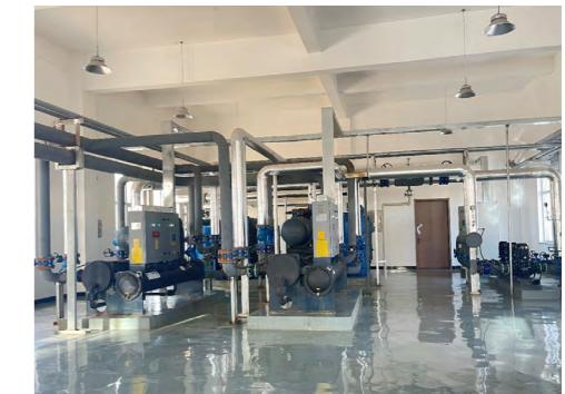
班定营污水处理厂污水源热泵机组
