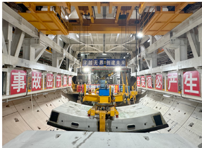
珠肇高铁 3 标圭峰山 1 号盾构隧道管片吊装
