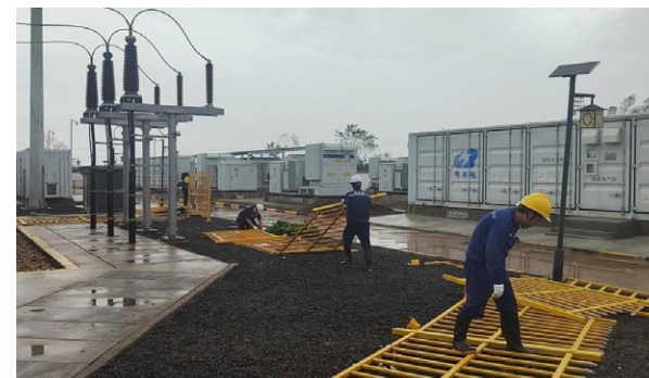
广东水电二局在台风“摩羯”后开展电站设施隐患全面排查工作
