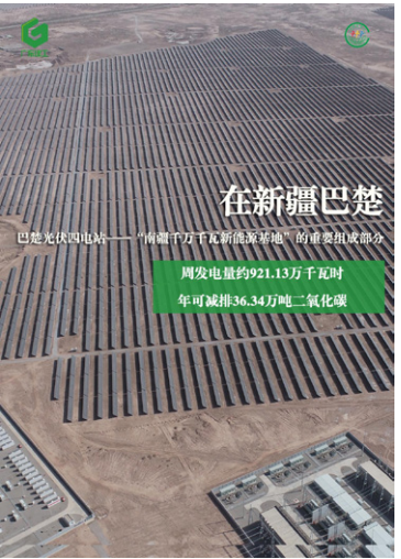
巴楚光伏四电站
