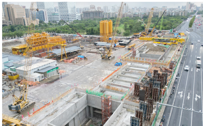
粤东城际铁路“一环一射线”项目时代广场站主体结构封顶现场
