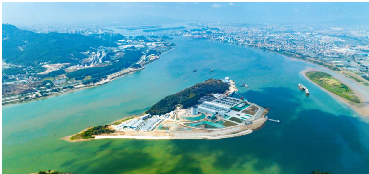
珠江三角洲水资源配置工程鲤鱼洲泵站
