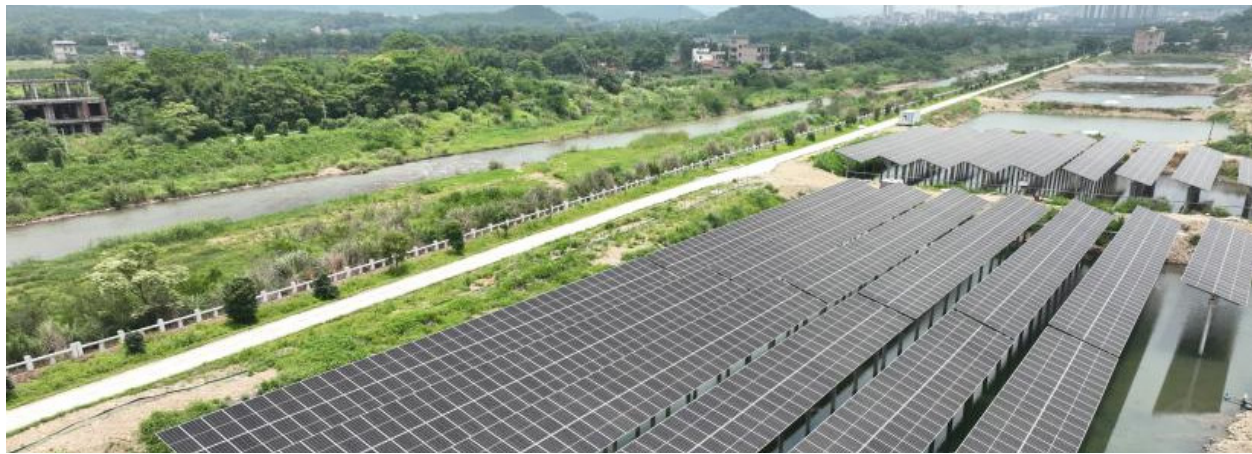
周田镇地面分布式光伏发电项目
