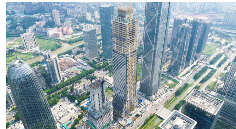
广州国际文化中心项目主体结构封顶现场
