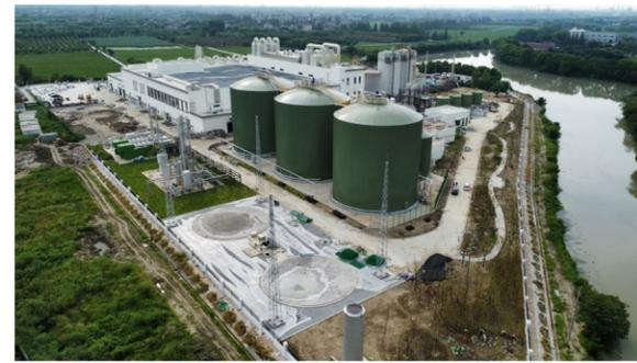
嘉兴餐厨垃圾处置项目设计采用“预处理+厌氧消化+沼气发电”为主体工艺，日处理餐厨垃圾能力最高可提升至1,005吨/日，实现有机废弃物的无害化、减量化和资源化处理，具有良好的经济效益和示范性作用。
