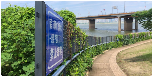
南昌市朝阳水厂取水口隔离护栏
