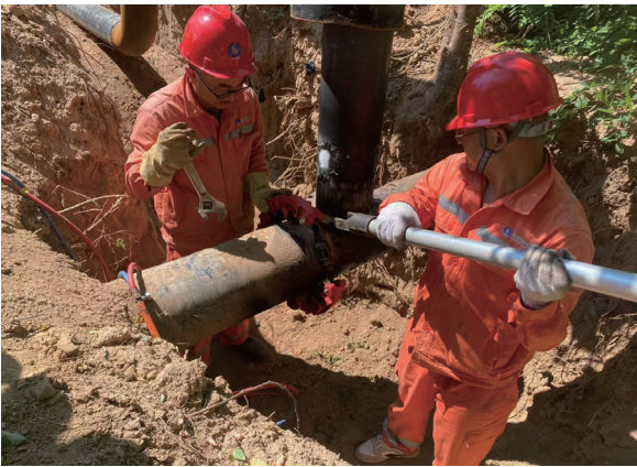
华新城燃维修二支队担任技术指导及作业人员顺利完成华新城燃平陆分公司工业支管道改造工作，保障管线供应效能。
