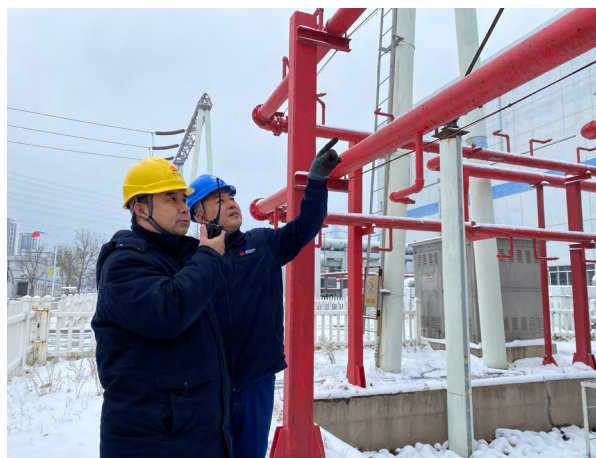
检查启备变运转情况
