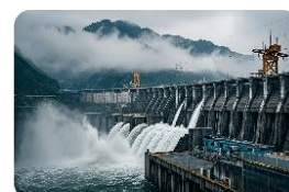
水力及抽储设备 超 3,000 台
