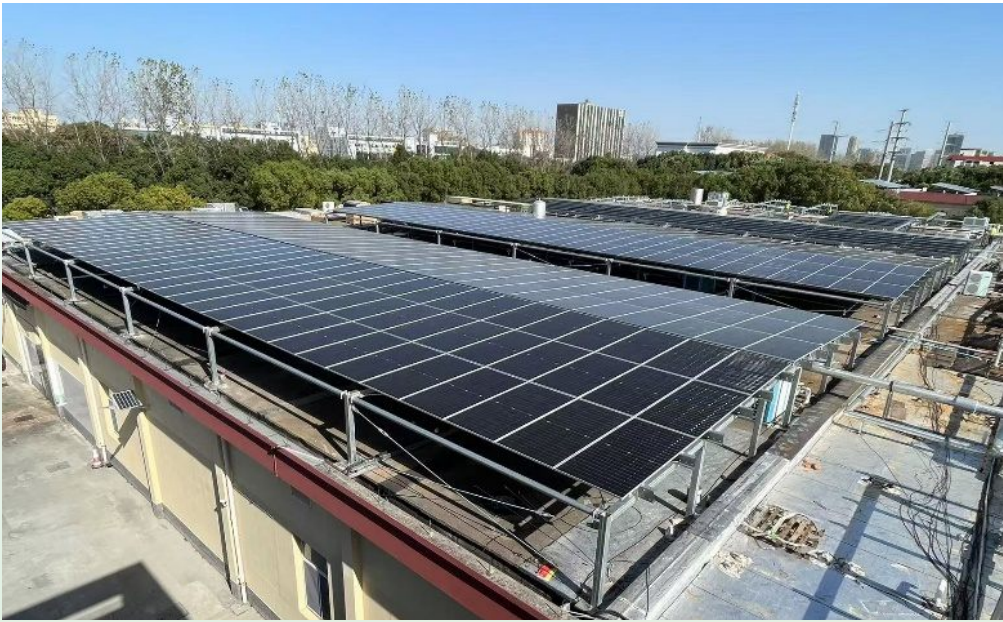
铺设屋顶光伏
