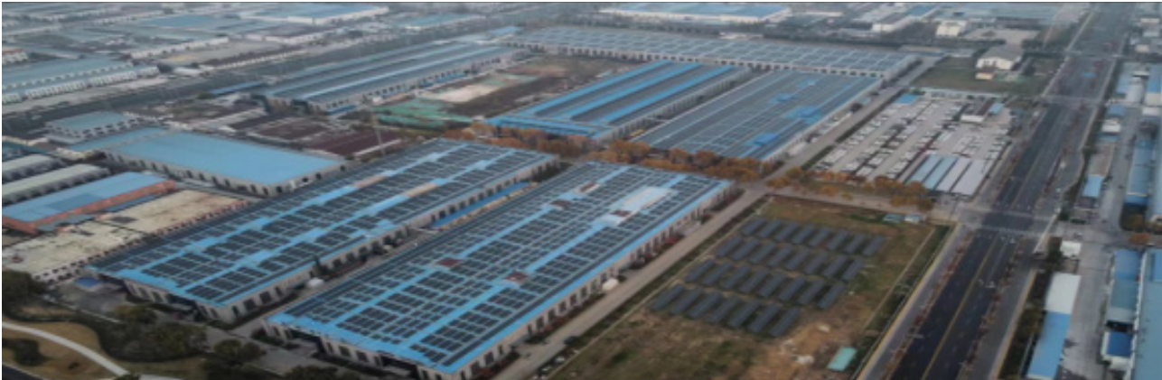
秀强厂区光伏发电屋顶
