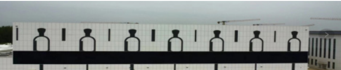
EPC 工程 - 古井贡光电幕墙
