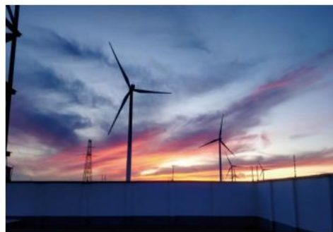
图七 新能源公司风电项目
