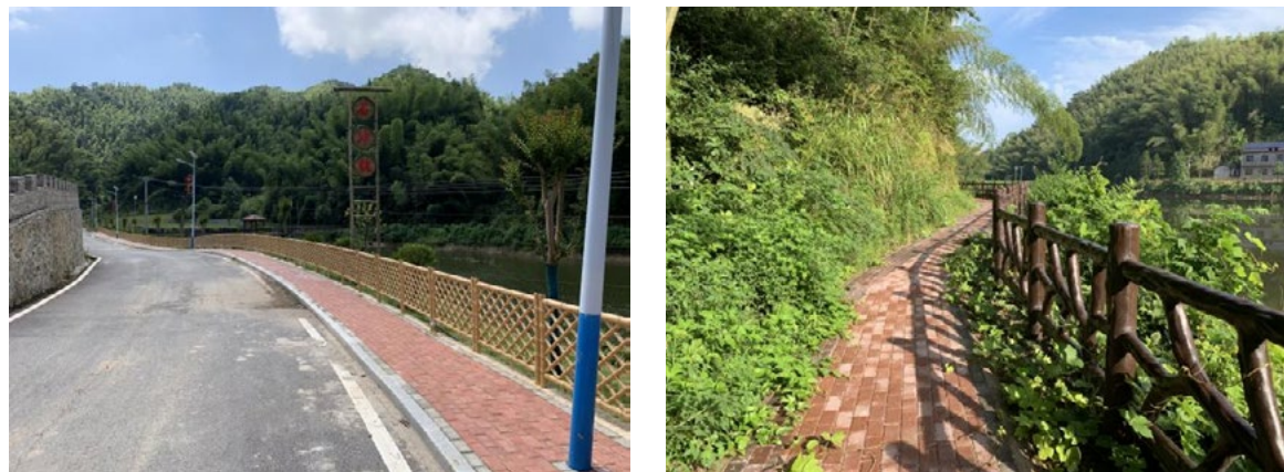
完工后的道路和游步道
