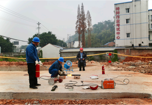
燃气公司所属运检中心抢险人员正剔除管道原始防腐层
