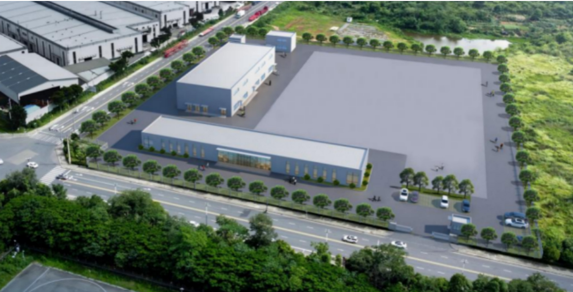
龙泉驿区储能电站
