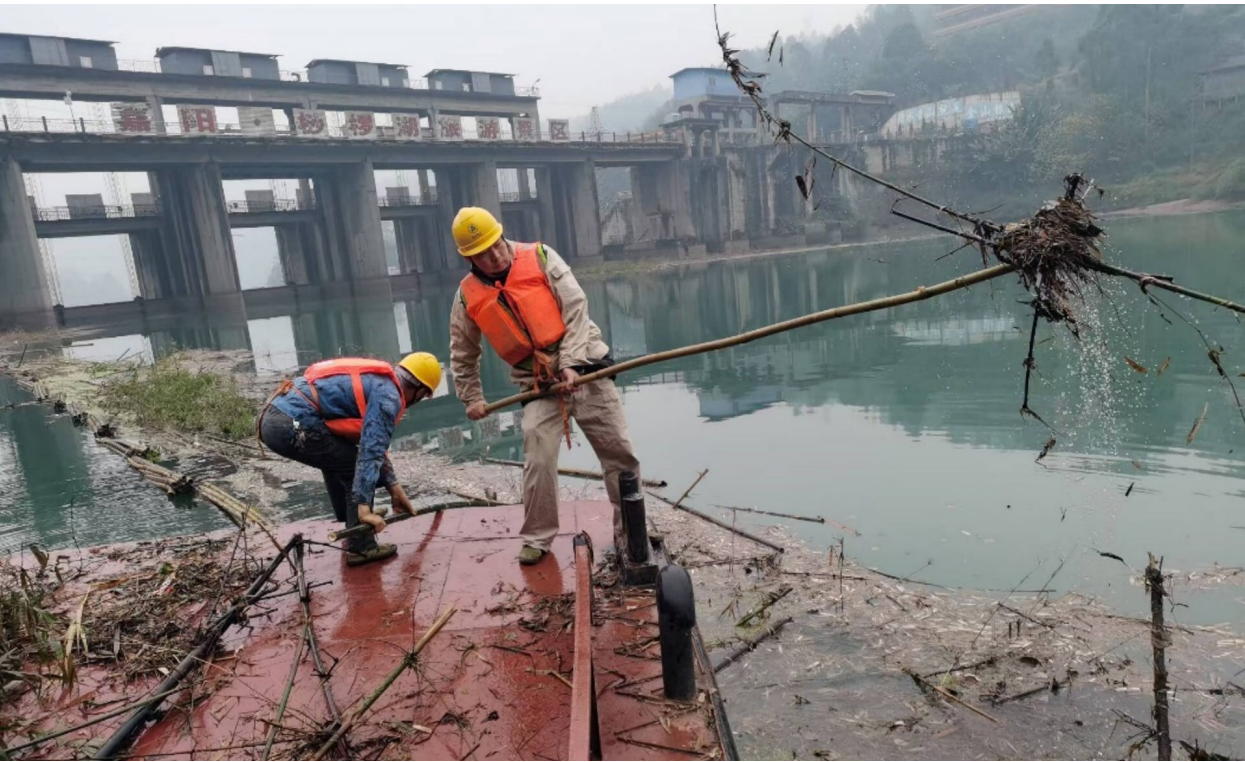
坛电厂打捞清理河面漂浮物和垃圾
