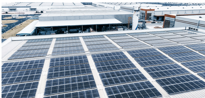
中际天津光伏项目
