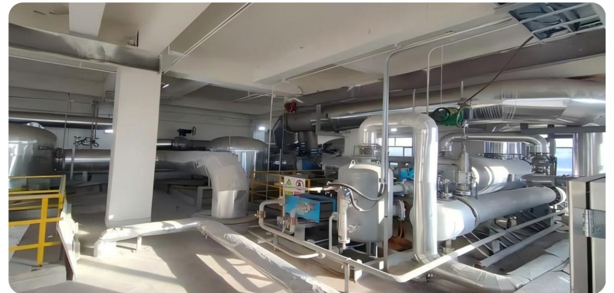
稀土钢铁厂烧结脱硫废水“三效蒸发”设备
