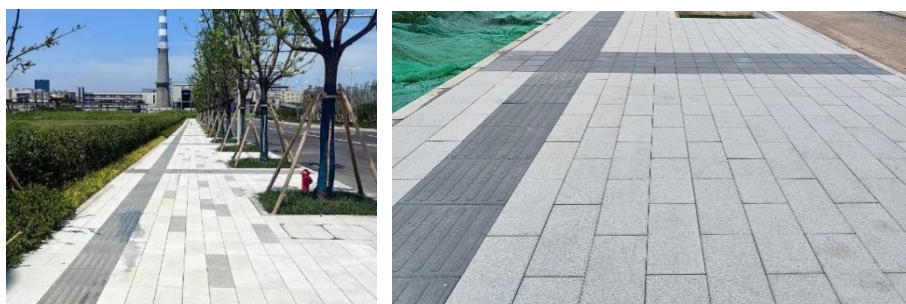
图：中新嘉善新湖路仿石透水砖、苏州工业园区嘉延路透水路面
