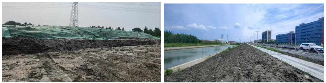
图：中新嘉善表层土壤收集归堆及回填利用
