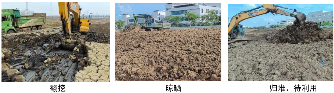
图：中新苏滁东望湖清淤土壤晾晒利用
