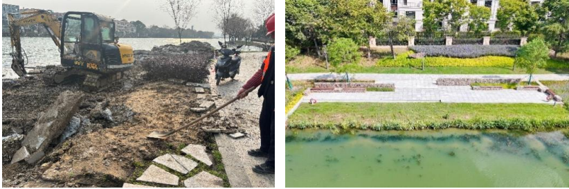
图：苏州工业园区环金鸡湖驳岸平台拆除后生态驳岸建设情况
