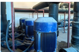
二期中央空调冷水机组淘汰电机更换
