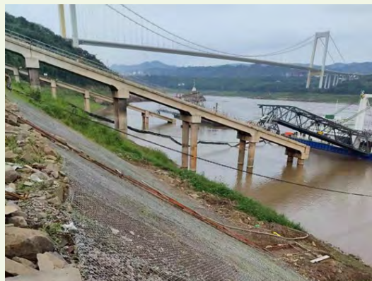
码头岸坡修复
