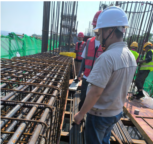
兰家沱一期改建安全检查
