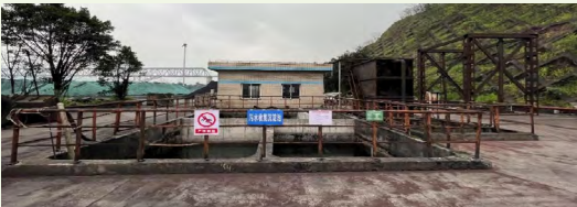
散货堆场沉淀池
