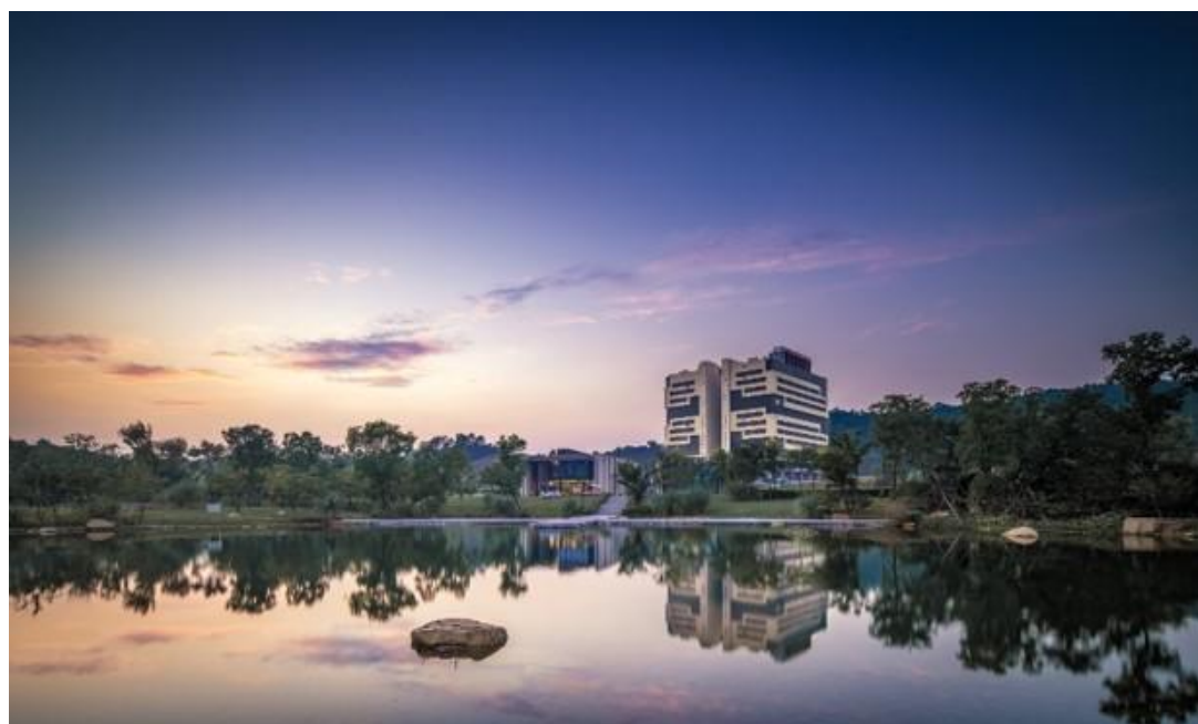
千岛湖数据中心通过自然水制冷方式降低 IDC 能耗
