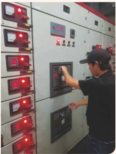
机房电源故障应急演练
