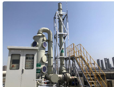
酸性废气处理系统改造
