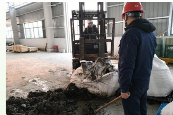
清理泄漏的污泥
