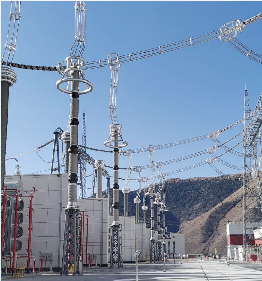
案例：1000kV 高抗震避雷器实景图
