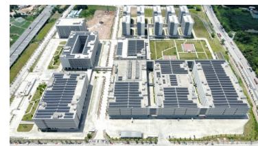
东莞第二制造中心光伏项目
