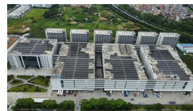
东莞第三制造中心光伏项目
