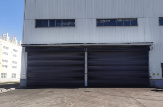
原煤棚配置封闭卷帘门
