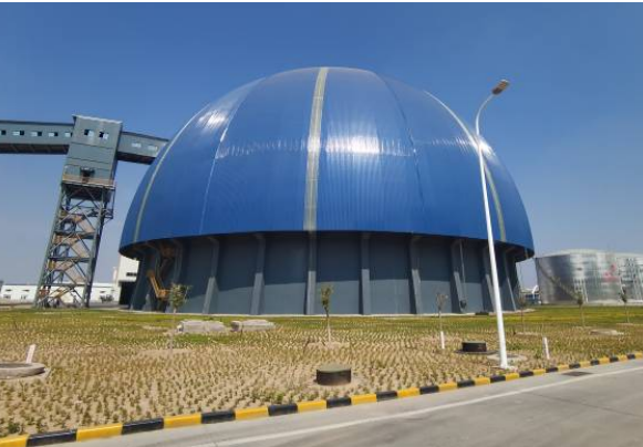
全封闭储煤棚
