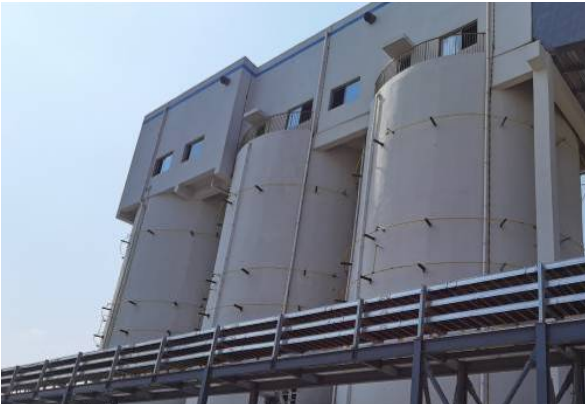
封闭混煤筒仓
