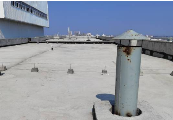
原煤仓顶排气筒
