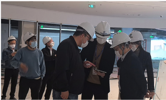
世荣万达广场项目安全防范巡检现场
