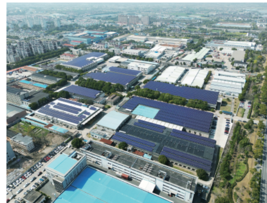
上海亨井智造基地光伏设施
