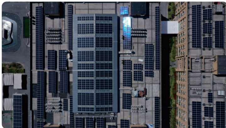
杭州制造基地光伏项目
