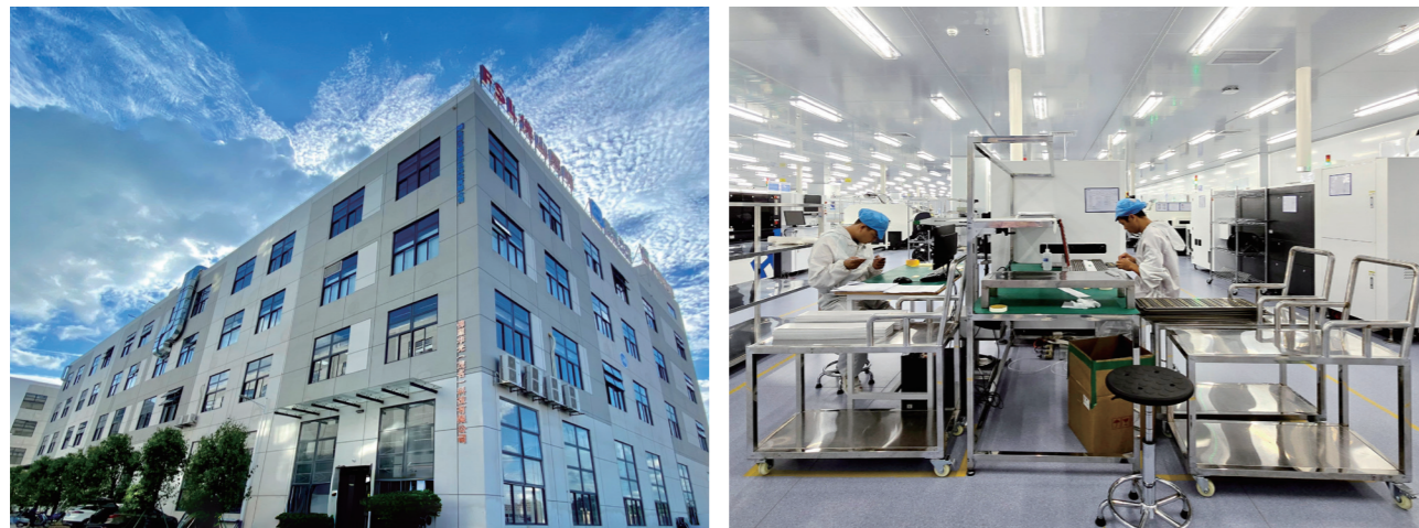
佛山照明高州生产基地与国星光电高州生产基地生产线
