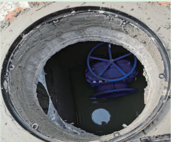
▲ 雨水管网调节阀门
