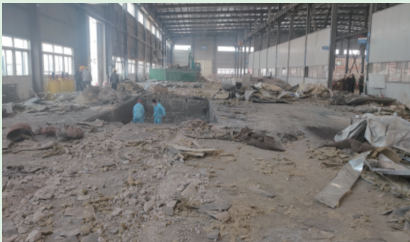
▲ 水帘喷漆房拆除
