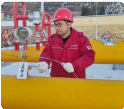
西山公司技能大师工作室开展增压设备维修技能培训
