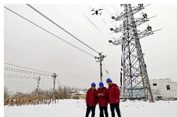
无人机巡检供电线路
