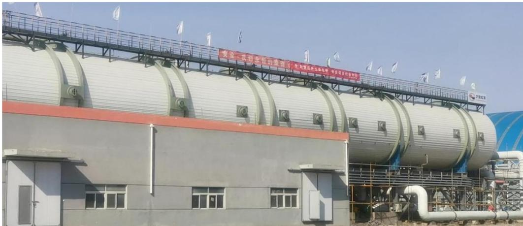
除了常规通用技术外，公司综合考虑热法以及膜法的技术特点，将低温多效热法系统与膜法系统结合成耦合系统，开发出热膜耦合海水淡化技术，并已成功应用于河北丰越能源科技有限公司 10 万吨/天（3×2.5 万吨/天膜法以及 2.5 万吨/天热法）海水淡化项目中。该项目系国内海水淡化项目中少有的利用“反渗透膜+低温多效”（即热膜耦合）工艺的项目，也是少有的海水淡化处理规模在 10 万吨/天及以上的由国内公司承做的项目。
