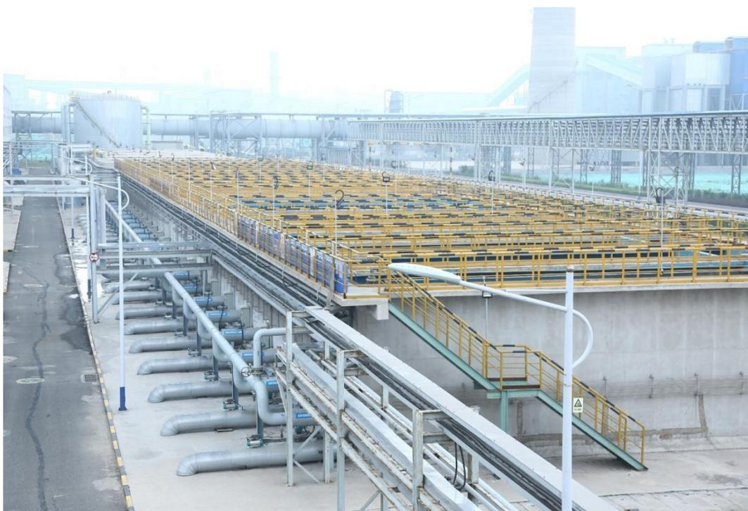
低温多效蒸馏（热法）海水淡化的基本原理是，通过海水蒸发将和盐分离的水蒸气回收利用，具体过程为海水经冷凝器预热后，被喷淋在传热管上，通过吸收管内蒸汽的潜热而蒸发，同时管内蒸汽放热冷凝为淡水，管外蒸发得到的二次蒸汽进入下一效（这里的“效”指“腔室”）传热管被冷凝，而浓缩海水则被排出；由于蒸汽自身温度在经过每一效传热管时会逐步下降，因此需要通过抽出每一效蒸发罐的部分空气，保持一定的真空状态，逐步降低蒸发罐内的蒸发温度，保证后一效的蒸发温度低于前一效；通过这一流程，可得到相当于输入蒸汽量数倍的蒸馏水。
