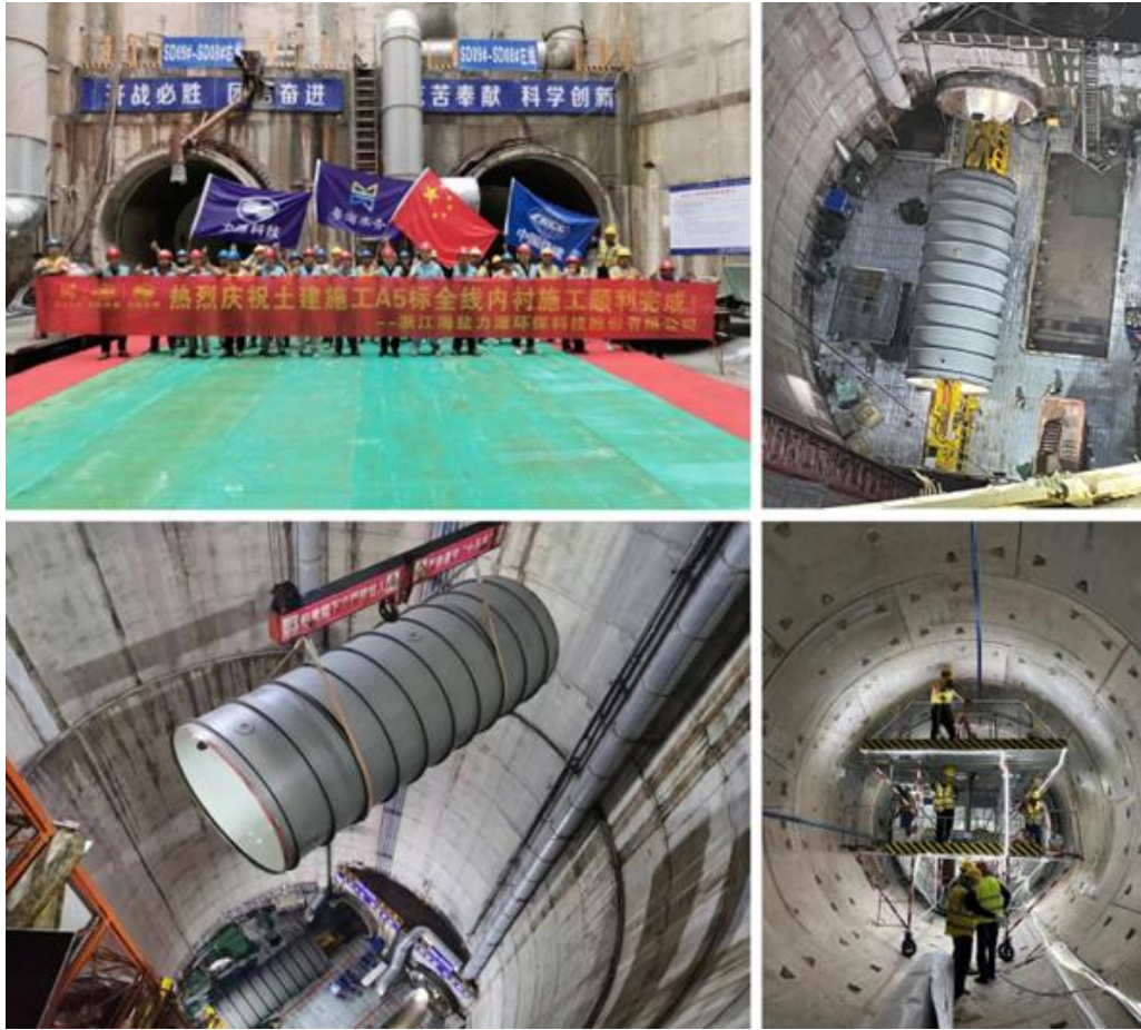
珠江三角洲水资源配置引水工程项目
