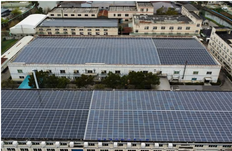
本厂1118KW屋顶光伏项目
