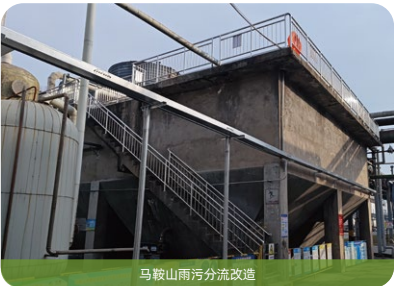
马鞍山雨污分流改造
