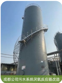
成都公司污水系统厌氧反应器改造
