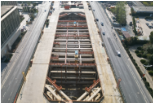
上海示范区线1标青浦新城站项目
