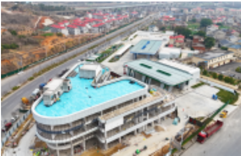
湖北大冶市城乡一体化综合能源站EPC项目 大冶东综合能源站
