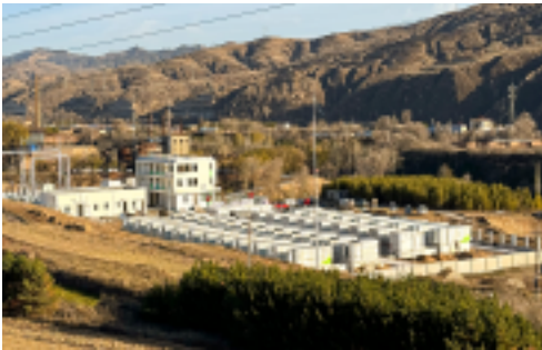
中电金谷偏关混合储能独立调频电站建设项目
