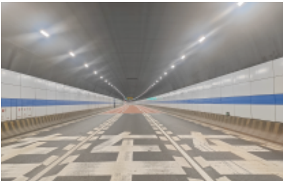
上海长江隧道照明改造工程
