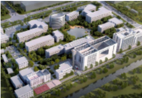
上海市检测中心二期天然气能源费用托管服务
