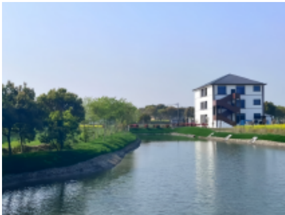
上海奉贤区柘林镇生态清洁小流域河道综合整治工程
