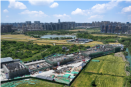
沪苏嘉城际铁路曹庄站项目
