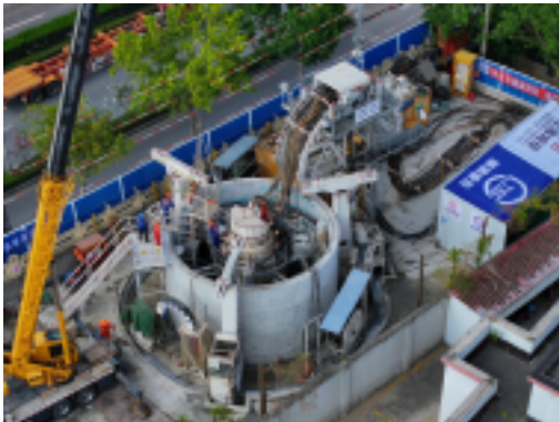
泰和污水处理厂扩建工程THK1.2标项目
