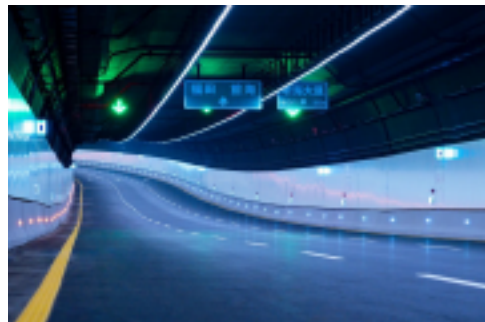
隧道股份上海隧道助力妈湾海底隧道主线通车
