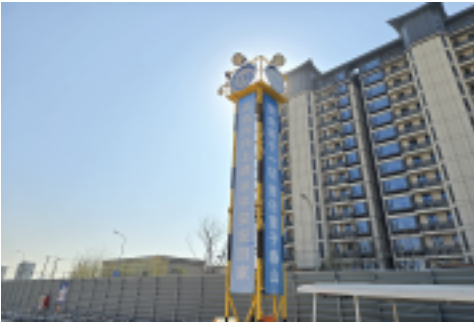
施工区照明角度、位置合理
