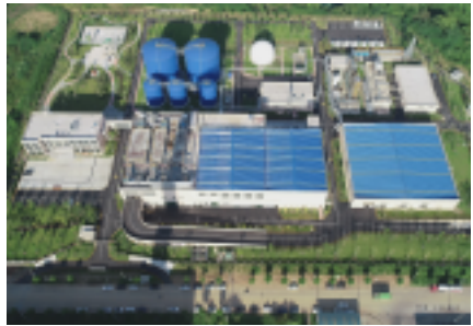
江西九江市城镇污泥和餐厨垃圾处理处置工程
