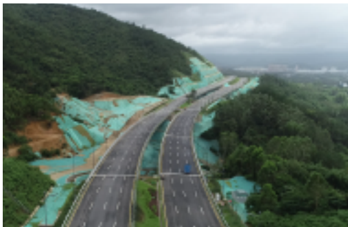
深汕通港大道工程
