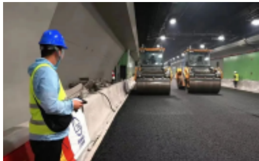
上海北横通道路面铺设工程
