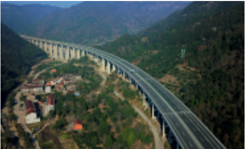
隧道股份城市运营开展公路维修及交通干线安全设施维护服务
