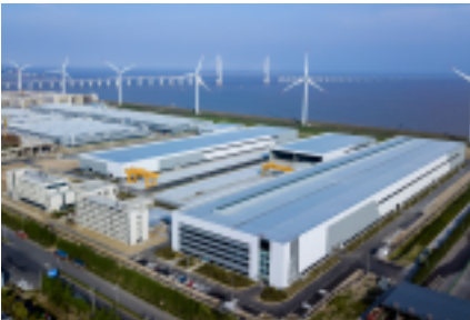
上海隧道海盐构件智造工厂
