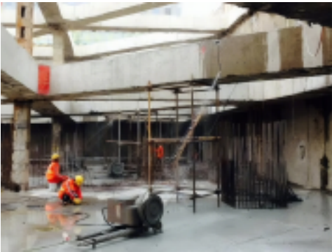
绳锯静力切割减小噪音
