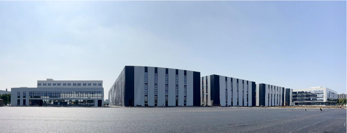
上图为嘉兴基地实拍图 德国合兴科技生产基地位于德国斯图加特，已于 2024 年 12 月完成奠基，厂房建设在有条不紊地推进中。其建成后，主要面向欧洲市场，将使公司更紧密地贴合欧洲客户需求，深度参与欧洲区域汽车主机厂商及汽车零部件供应商的供应链体系。
