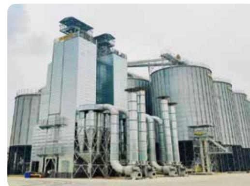
采用全负压烘干工艺，整机轻量化结构设计。将横流式通风降水、粮食循环和配套智能等技术相结合。
