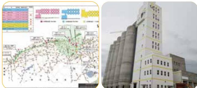
2013年，中粮科工提供承建阿尔及利亚35万吨混凝土粮仓建设项目的全部工程设计和储粮技术。该项目是阿尔及利亚40多年来启动的首批大型粮仓建设项目，分布在9个省的主要粮食产区，目前9座粮仓均已投产运营。在投入运营不到3年的时间里，新粮仓因鼠害、虫咬、霉变等导致储粮减损程度由旧粮仓的9%下降到2%以下。
