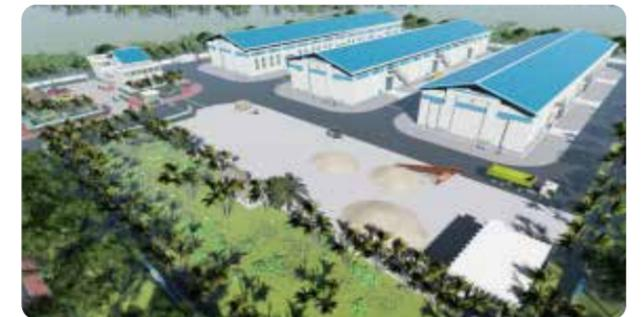
该项目是位于莱索托马塞卢的粮仓，用地面积20000平方米，建筑面积5500平方米包含3栋平房仓式综合粮，1座综合服务楼。
