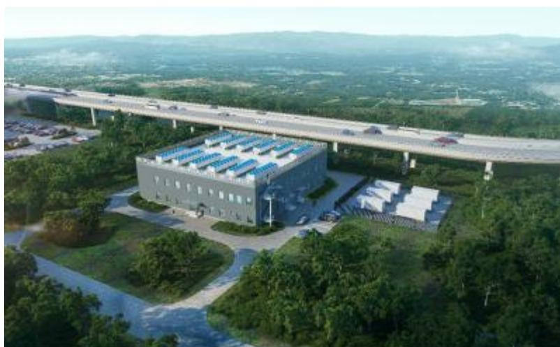
某机场建筑能源“零碳”项目：本项目实施范围包括机场地源、空气源一体式二氧化碳空调热泵系统和末端系统改造工程等。项目采用以跨临界二氧化碳冷热一体化系统为核心，结合绿电、地热、储能等技术，实现机场冷、热能源一体化供应的技术，以达到零碳排放的目标，并致力于打造国内“零碳机场”示范项目。
