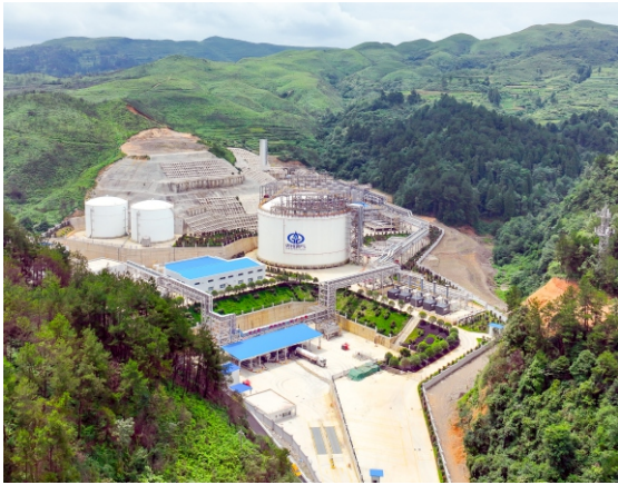
花溪LNG应急调峰站
