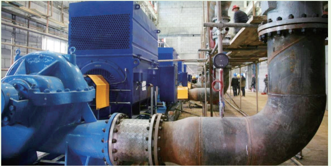
老旧小区供热管网改造
