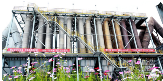
公司冶金尘泥综合利用产线通过分离和高效回收固废原料中的铁元素和锌元素，实现固废资源再利用和零出厂，实现经济效益与环境效益双赢。
