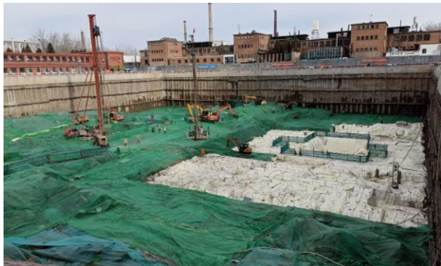
电子城有限26#地项目裸土覆盖绿色土工布
