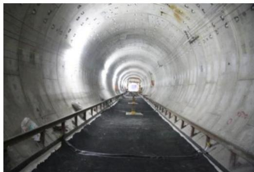
隔离式橡胶减振垫使用效果图
