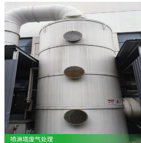
喷淋塔废气处理
