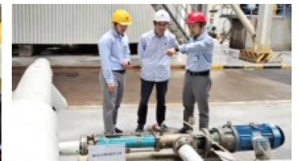
浙能电力总工程师现场查看设备运行状况
