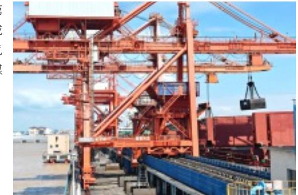
浙能嘉电码头正在24小时抢卸中
