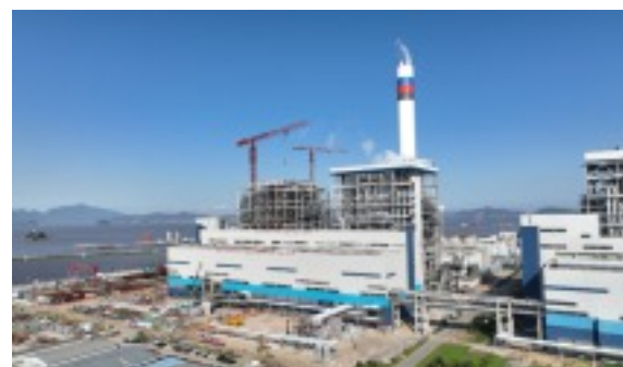
浙能舟电六横二期4号机组正稳步有序推进土建和设备安装、调试等工作
