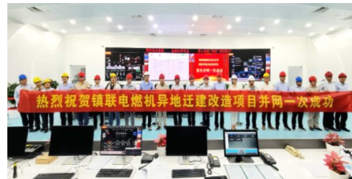
浙能镇联电燃机异地迁建项目首次并网一次成功
