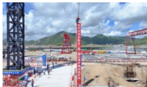
浙能台二电二期4号锅炉首根钢结构吊装现场
