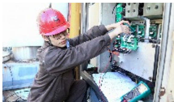
改造中设备管理部点检正进行分步调试
