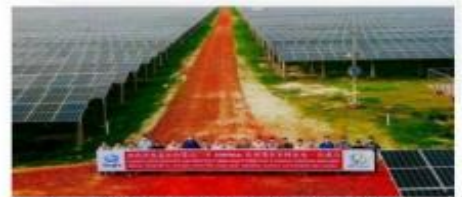
▲ 孟加拉国迈门辛市50MWac光伏项目
