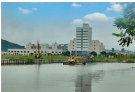
九龙江河口段水系综合整治（浮宫片）项目工程
