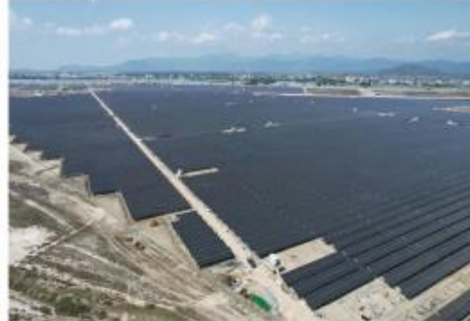
莺歌海盐场100MW平价光伏项目
