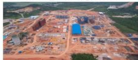
▲ 印尼宾坦动力中心、BAI项目三期氧化铝地基处理工程
