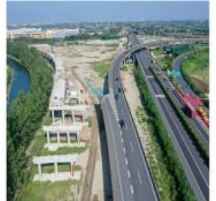
■ 沪武高速扩建董浜枢纽段
