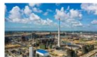
中科(广东)炼化一体化项目
