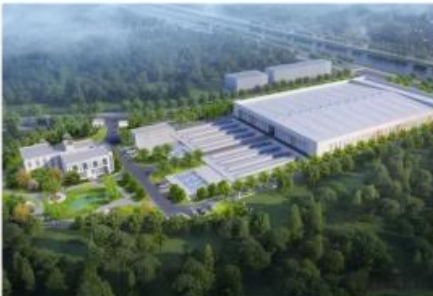
顺德区大良勒流水体综合整治工程—优先实施子项工程（一期）工程项目
