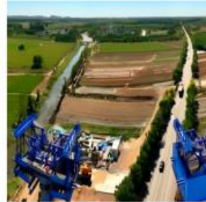
■ 雄商高铁衡水枢纽站前 一标项目桩基工程
