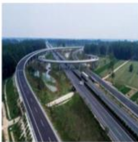
■ 阜溧高速公路建湖 至兴化段
