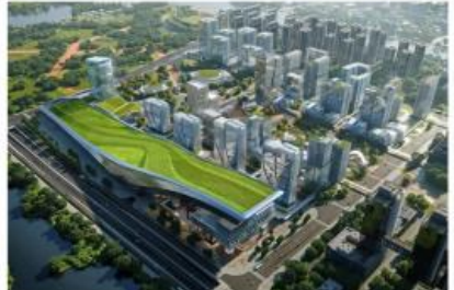
■ 深圳前海,冰雪世界基坑支护及 桩基础工程
