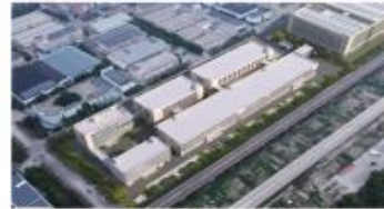
绍兴拓宇新能源太阳能电池环保高效新材料项目
