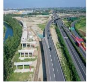
沪武高速扩建董浜枢纽段
