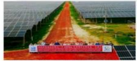
▲ 孟加拉国迈门辛市50MWac光伏项目
