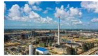
中科(广东)炼化一体化项目
