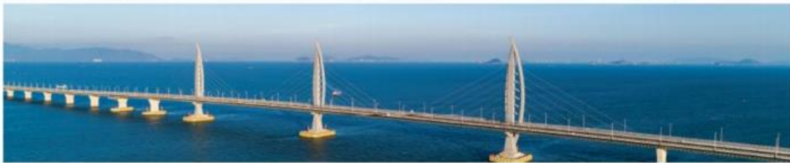
港珠澳大桥工程项目
