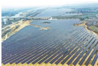
麻城市多能互补百万千瓦新能源基地项目
