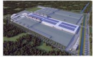
山东爱旭科技济南基地10GW高效晶硅太阳能电池组件项目
