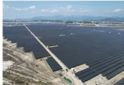
莺歌海盐场100MW平价光伏项目
