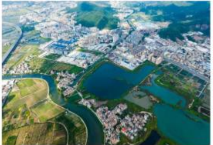
■ 茅湾涌防洪排涝整治工程
