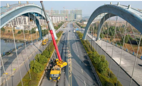
青洋路高架修复维保工程
