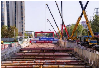
成都轨道交通13号线一期工程
