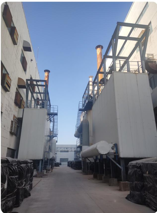
隧道窑干法脱硫设备
